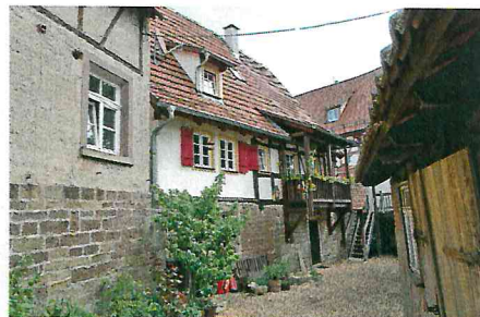
Blick in den Burggraben
